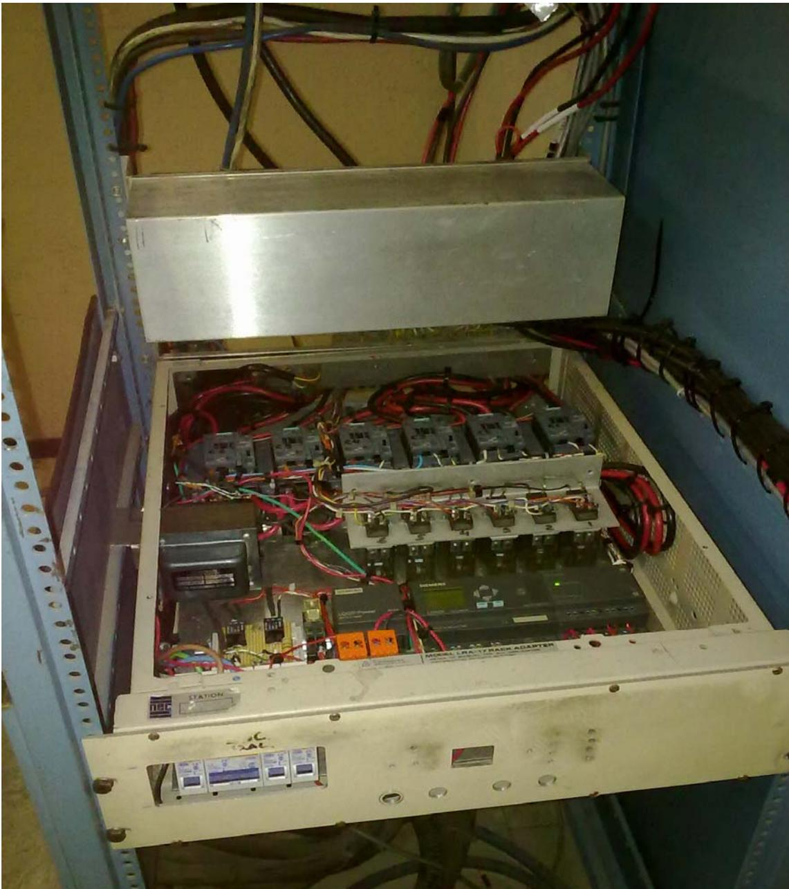
**I6**-Vista del gabinete con el selector de cuadrupolos ya montado y cableado en el rack
