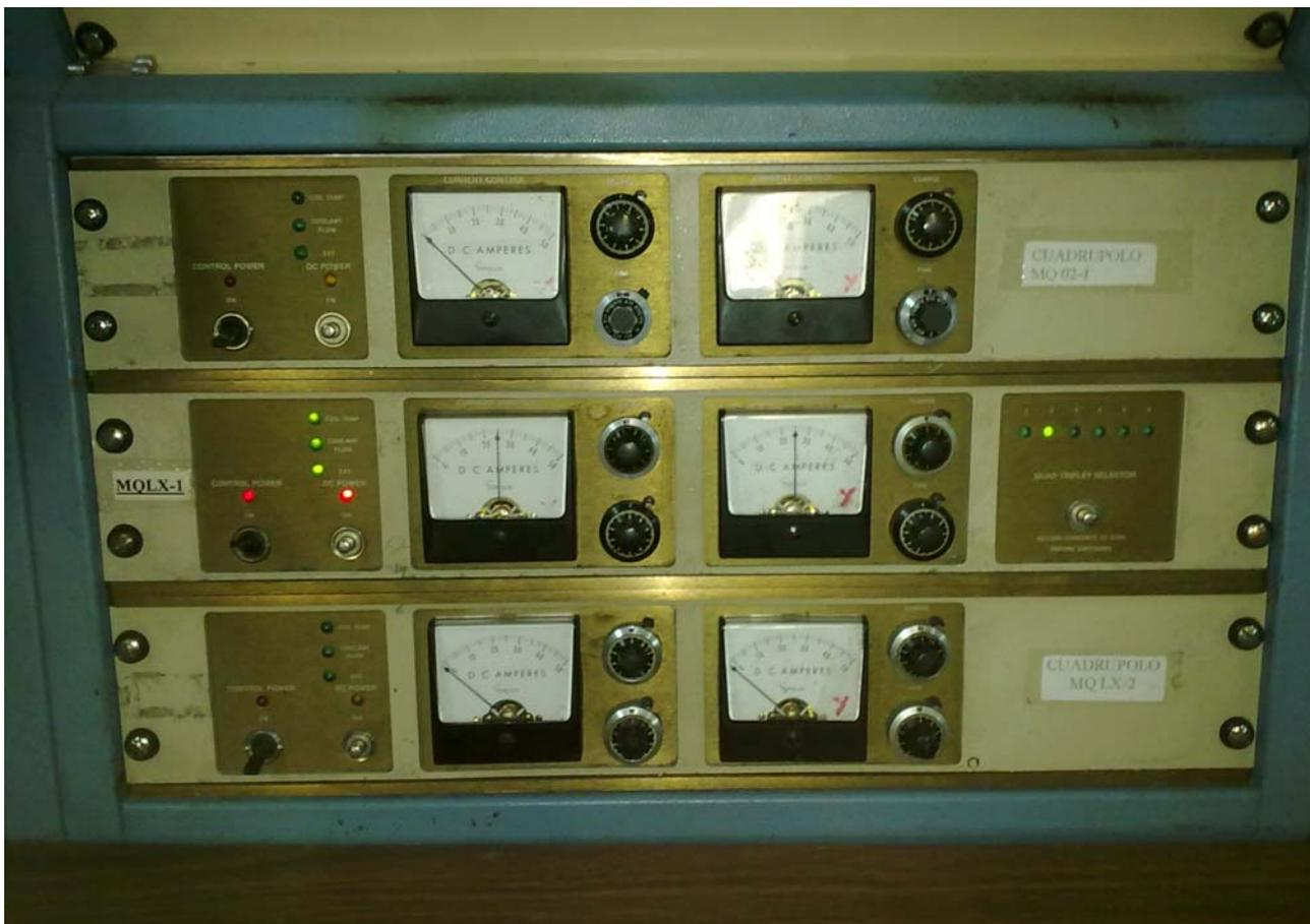
**I10**-Vista del panel del selector de cuadrupolos en la consola de control, conectado el cuadrupolo de la línea 2 (Línea Experimental Cámara Multipropósito) funcionando a 25 amperes durante las pruebas.
