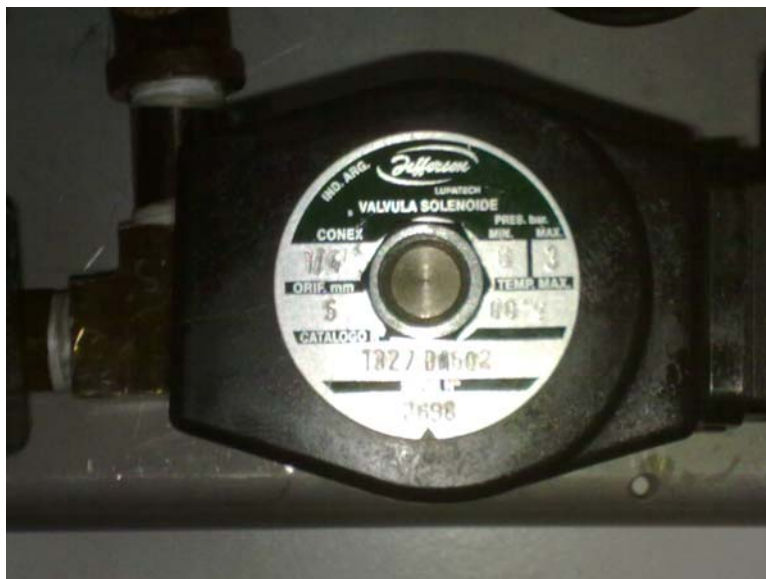
Fig. 6 chapa de características de las válvulas solenoides.
